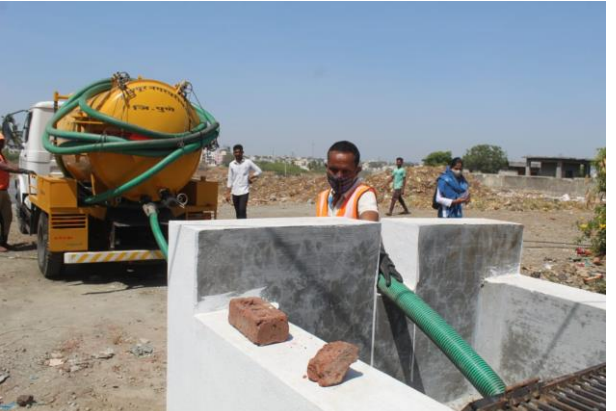
FS unloading at FSTP
